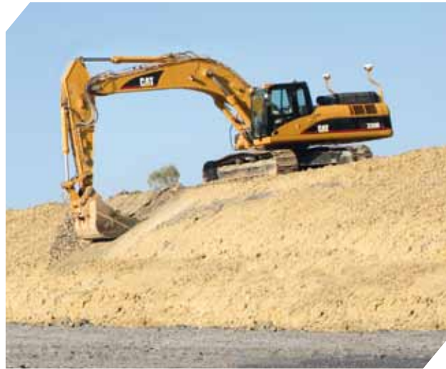
Budování násypů a protihlukových stěn
