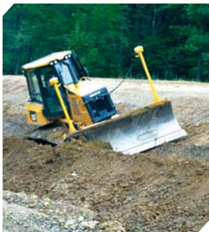
D6K LGP s duálním řízením GPS při svahování
